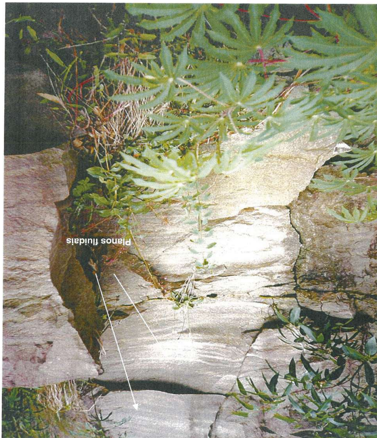
Fig. 10.7 Riodacito pórfiro que aflora no talude da estrada de acesso à Pedreira Baldissera, limite leste da Área I. Observam-se os planos fluidais sub-horizontais da rocha, que se constituem em planos de fraqueza, por onde a rocha tende a fraturar.
